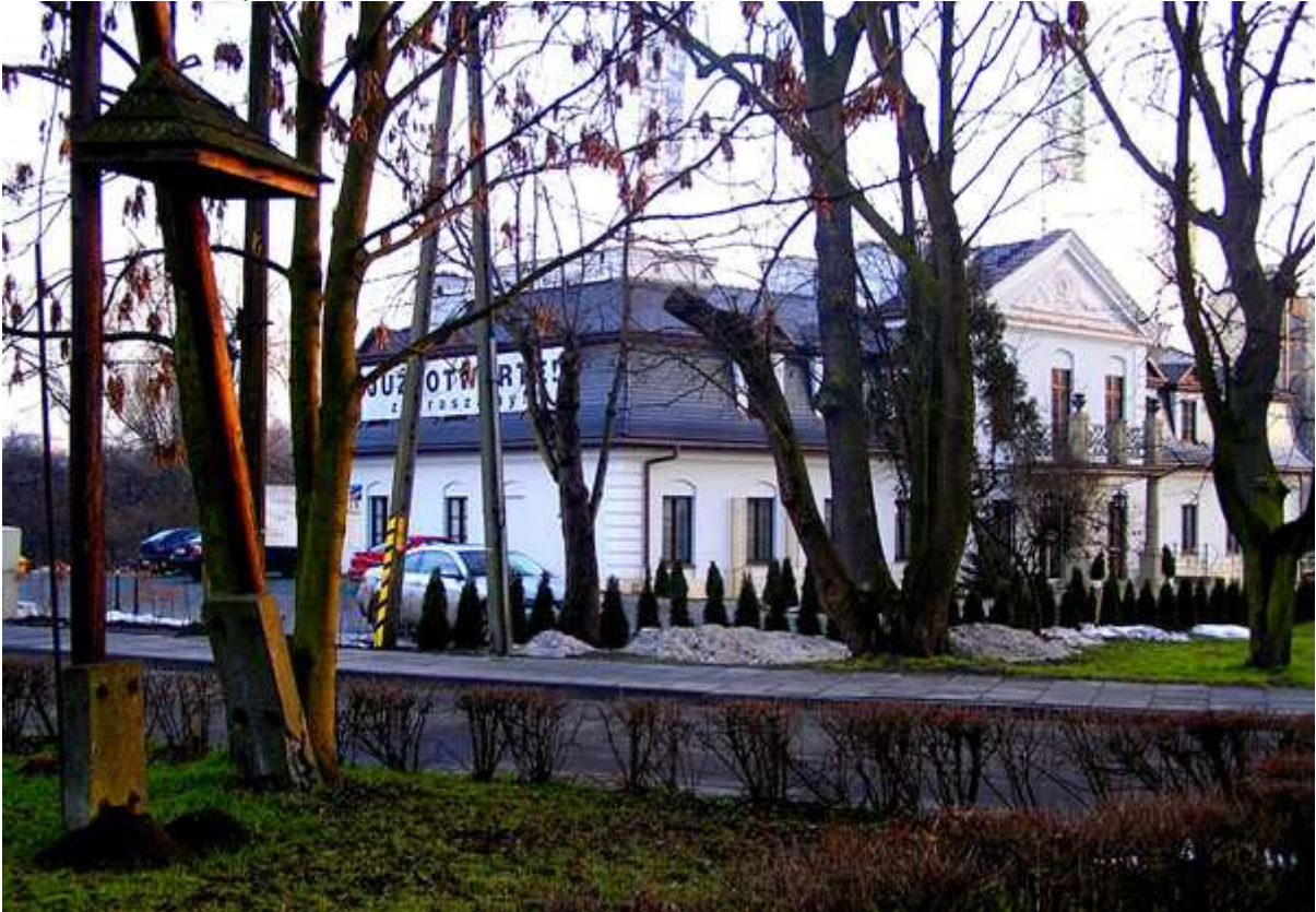
Hotel od strony Dworku
